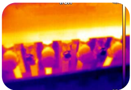
8. Rückschlagventile der Fußbodenheizung verteilen
